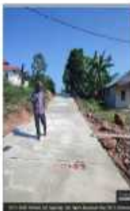
Pembangunan Semeniran Jalan
