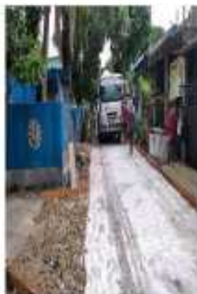
Pembangunan Desa/Desa Jaten
