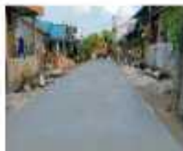
Pembangunan Sarana Jalan
